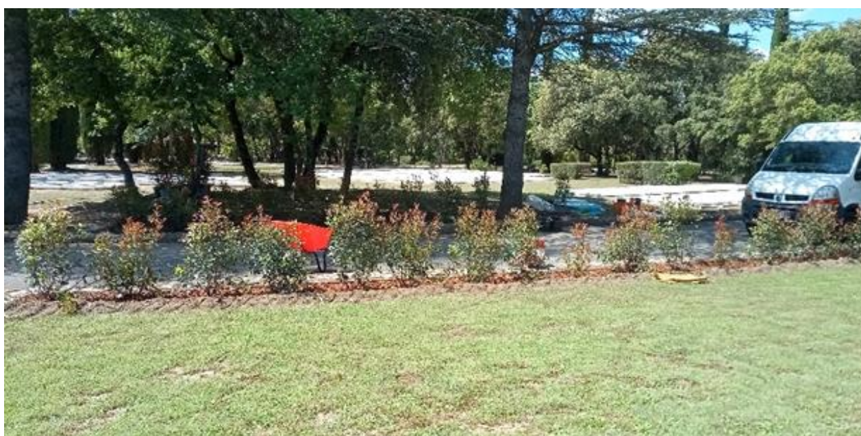
08 mai fin des plantation et rempaillage, préparation et installation système d'arrosage
