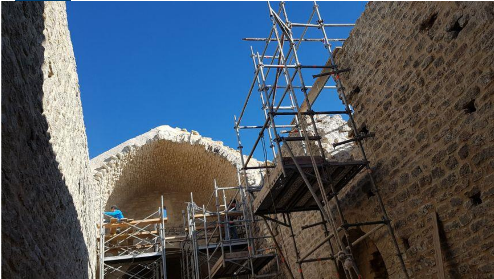
chapelle Saint Hilaire en pleine reconstruction © Radio France - Philippe GARCIA
