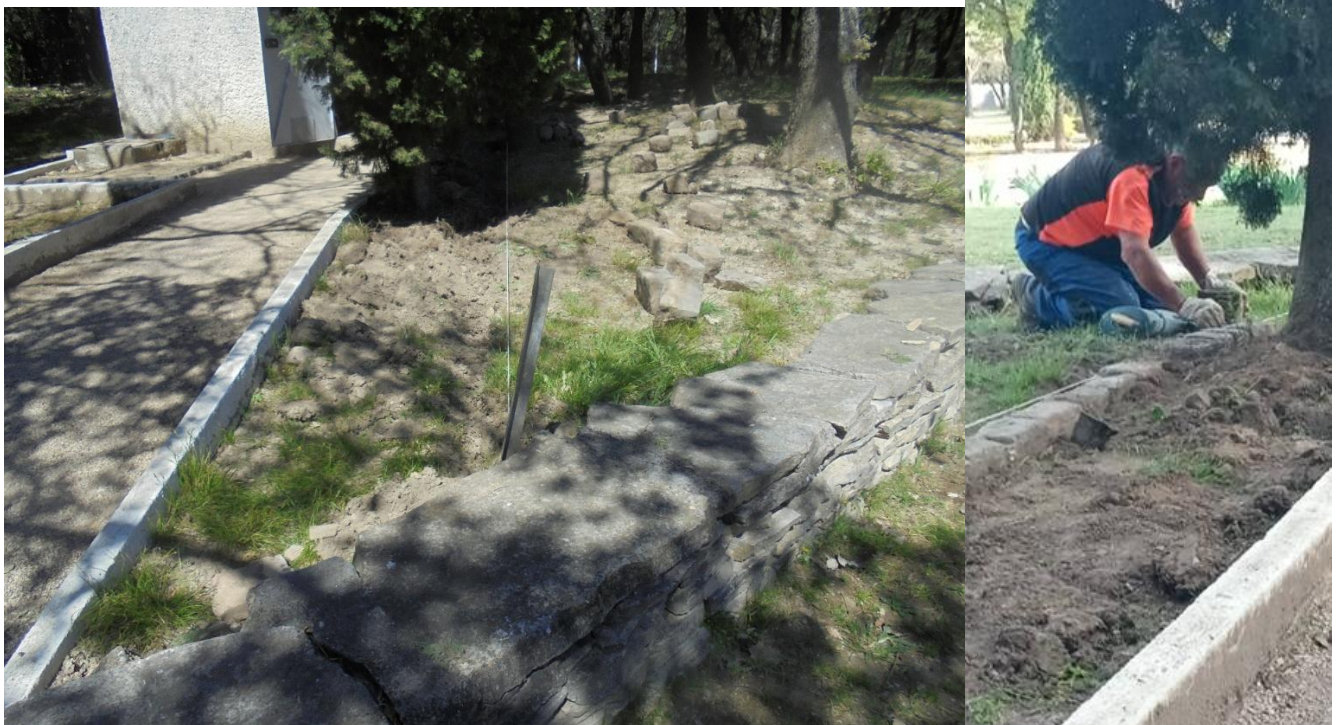
Jardinière locale, pompe en construction
