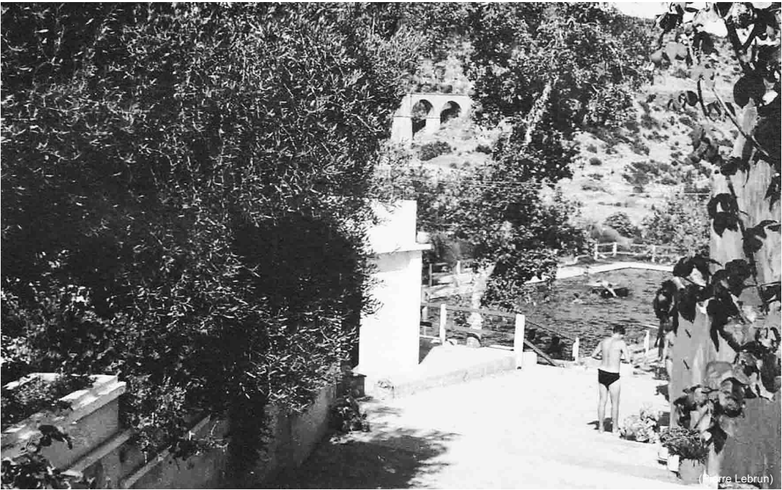
EALA 4/72 – Piscine de Tagdempt à Tiaret, 1959
